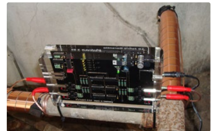
Installation de Vulcan dans un immeuble d'habitation
