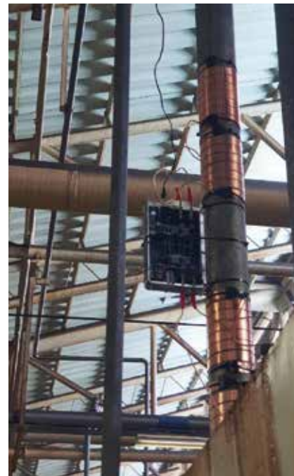
Vulcan S25 a été installé à quelque 50 mètres en amont de la machine de trempage par induction.
