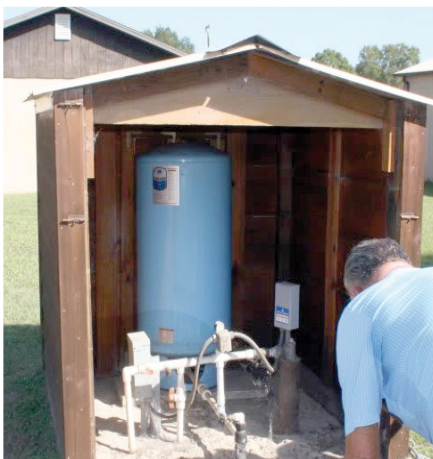
Système d'approvisionnement en eau de forage domestique
