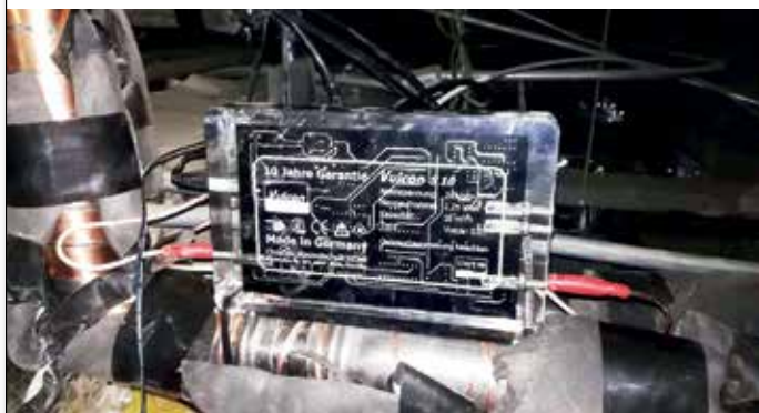
Vulcan S10 a été installé sur la conduite d'eau principale de la cuisine chinoise.
