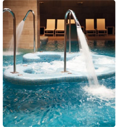
Piscine thermale à base d'eau de mer
