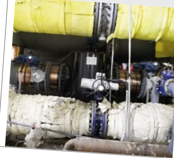
Étape 2 : Installation extérieure, couche d'isolation des tuyaux, deuxième unité X-Pro dans la boîte de protection
