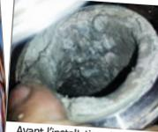
Avant l'installation de Vulcan : Le tuyau était recouvert de dépôts de calcaire.
