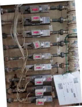
Il existe 9 petites conduites secondaires équipées de compteurs d'eau. Ces compteurs ont été installés pour s'assurer de la stabilité du débit. Le ralentissement du débit pourrait poser un problème au niveau de la machine de trempe par induction. Cela explique pourquoi les conduites devaient être nettoyées manuellement tous les 2 à 3 mois.
