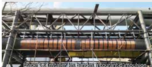
Étape 1 : Installer les bandes à courant d'impulsion
