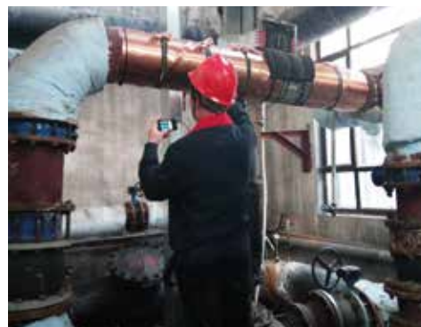
Vulcan S250 a été installé sur la conduite d'arrivée d'eau.
