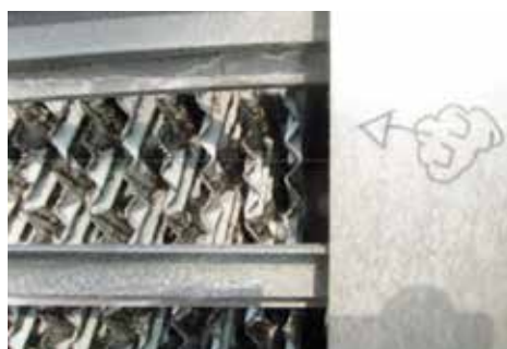
Avant l'installation de Vulcan : l'extérieur de la tour de refroidissement.
