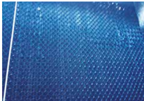
L'intérieur de la tour CT-1, 3 semaines après l'installation de Vulcan.
