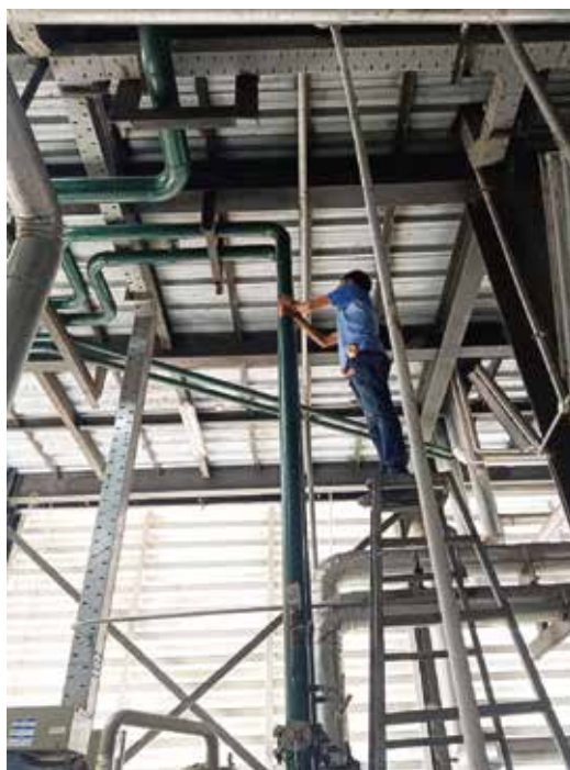
Installation de Vulcan S25 sur le nouveau refroidisseur.
