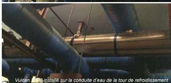
Vulcan S500 installé sur la conduite d'eau de la tour de refroidissement
