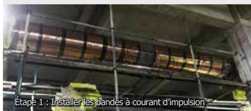
Étape 1 : Installer les bandes à courant d'impulsion
