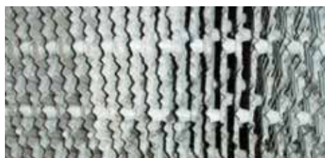
Avant l'installation de Vulcan : l'intérieur de la tour de refroidissement.
