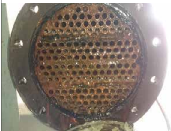
L'échangeur de chaleur avant l'installation de Vulcan
