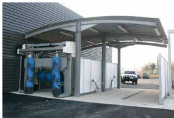
Station de lavage de Clerfond
