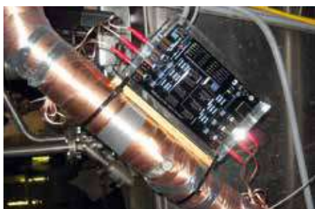
Appareils Vulcan S100 installés sur le dispositif de nettoyage
