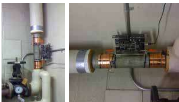
Installation du détartrant Vulcan au niveau de l'alimentation générale en eaux des bâtiments de l'école Roosevelt
