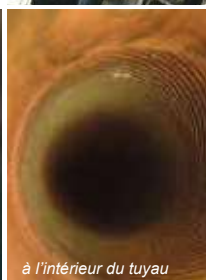
à l'intérieur du tuyau
