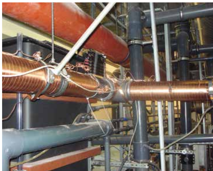
Vulcan S250 traitement de conduites principales d'eau de la piscine Meridan et zone de Spa
