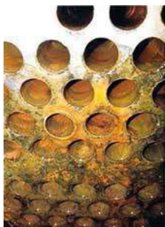
Première inspection : 4 mars 2014.
