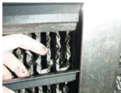
5 mois après l'installation de Vulcan : le calcaire s'enlève facilement à la main.
