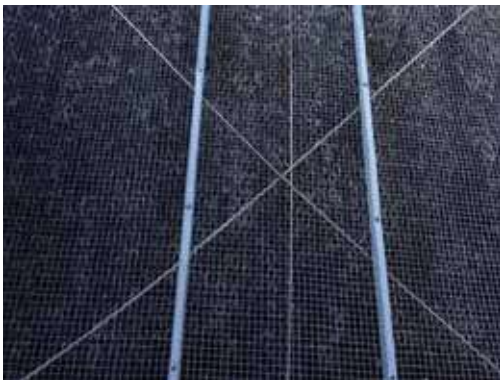
Ces photos montrent la tour CT-1 après six semaines de traitement
