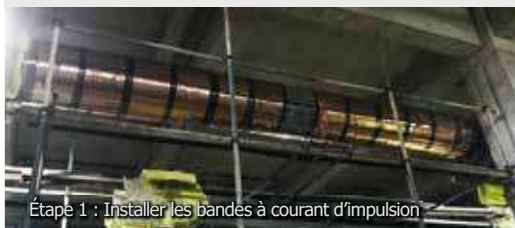
Étape 1 : Installer les bandes à courant d'impulsion
