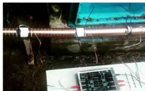
Photo 4. Installation de Vulcan sur l'arrivée d'eau principale.
