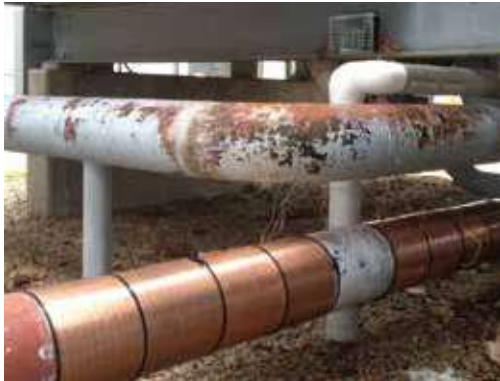
Vulcan S250 a été installé sur une conduite de 25,4 cm chargée d'alimenter deux tours de refroidissement (CT-1 et CT-2)
