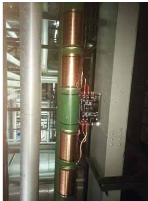
Vulcan S25 a été installé afin de traiter l'ancien refroidisseur.
