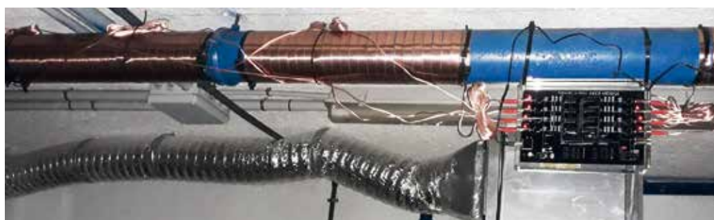
Étape 2 : Installer l'unité S250 sur la conduite d'eau
