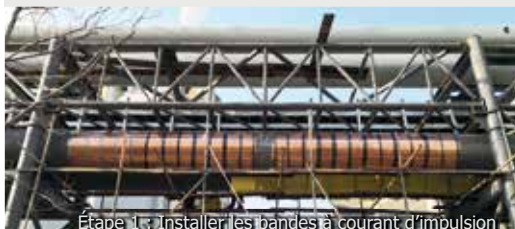
Étape 1 : Installer les bandes à courant d'impulsion
