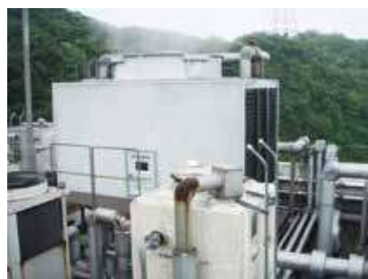
Le toit de la tour de refroidissement de l'entreprise pharmaceutique
