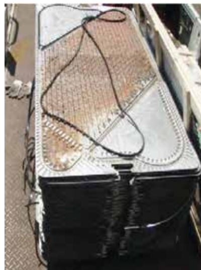
9 mois après l'installation de Vulcan : l'échangeur à plaques démonté pour être nettoyé.
