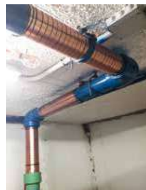
Étape 1 : Installer les bandes à courant d'impulsion
