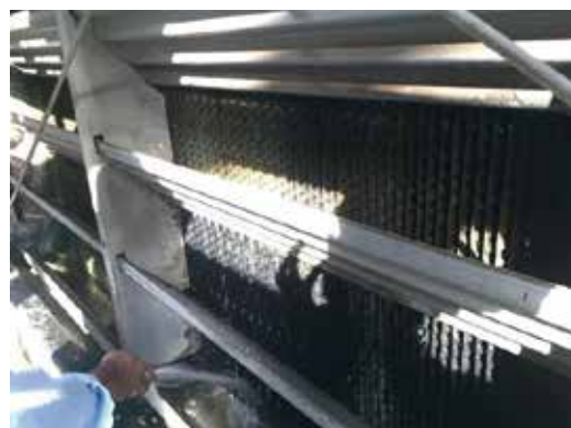
Le calcaire et les algues se suppriment facilement à l'aide d'un simple canon à eau.
