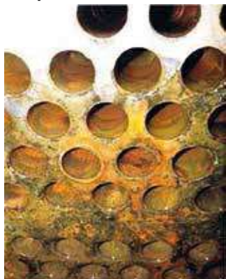
Première inspection : 4 mars 2014
