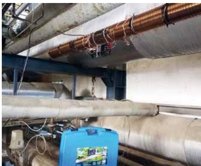
Vulcan S150 a été installé sur la conduite d'eau principale.
