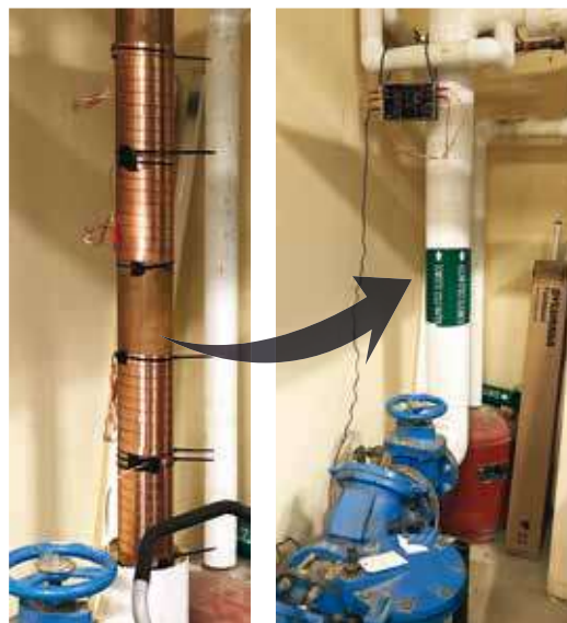
Étape 1 : Installer les bandes à courant d'impulsion
