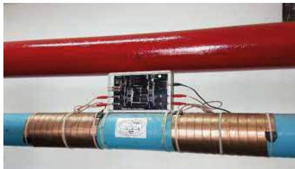
Le dispositif anti-calcaire électronique Vulcan S25 installé
